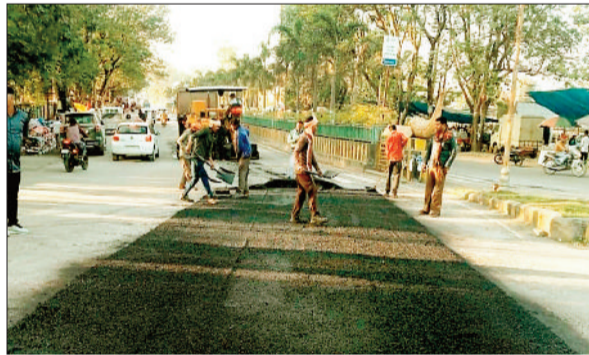
किया जा रहा सड़क का मरम्मत कार्य।
